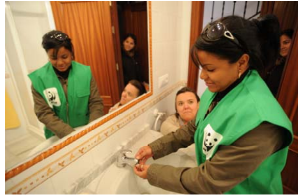
Instalación de un ahorrador tipo baño en Hinojos
