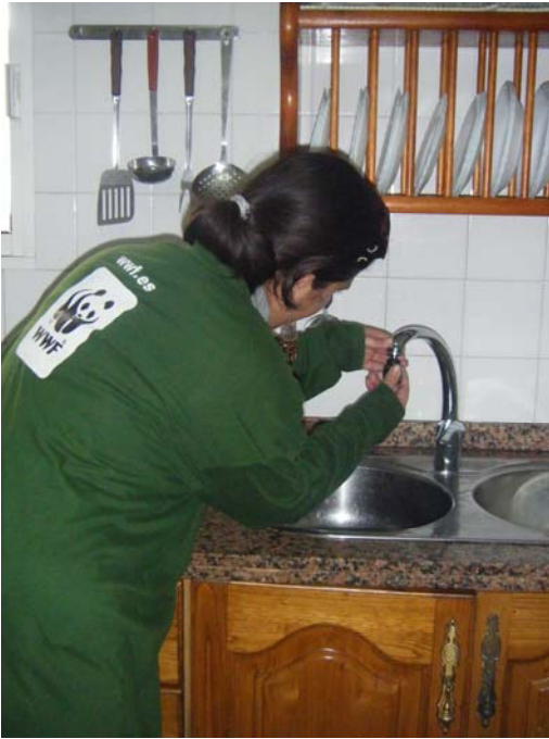
Instalación de un ahorrador tipo cocina en Almonte
