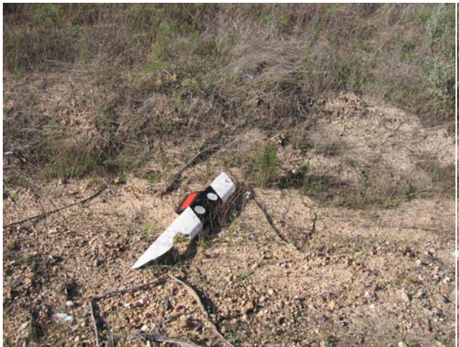
Elementos reflectantes rotos intencionadamente en el camino Villamanrique-El Rocío
