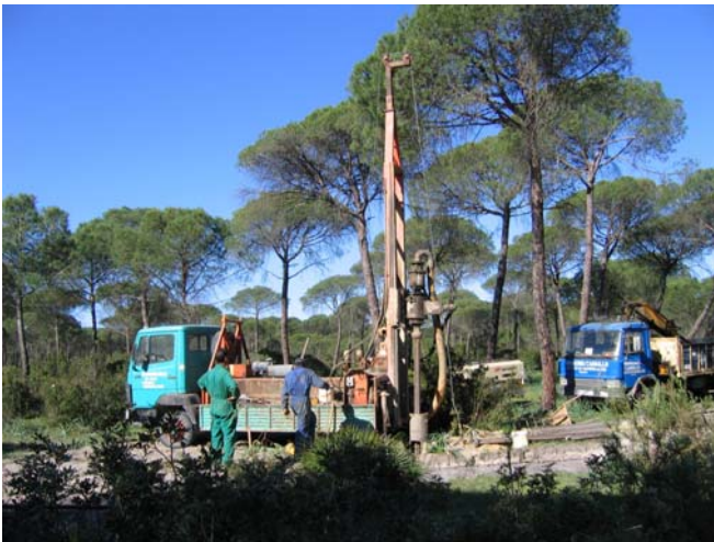
Construcción de un pozo nuevo en el Condado
