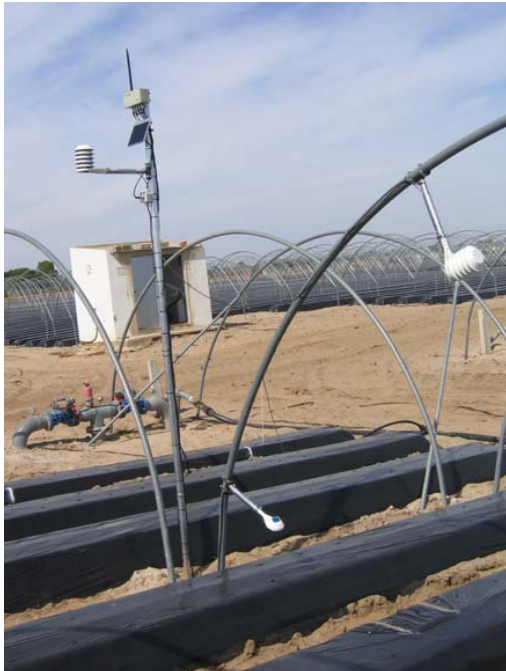
Detalle del sistema de ahorro de agua
